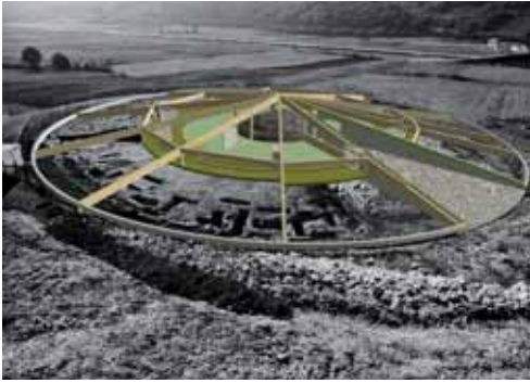
Struttura portante in legno lamellare
